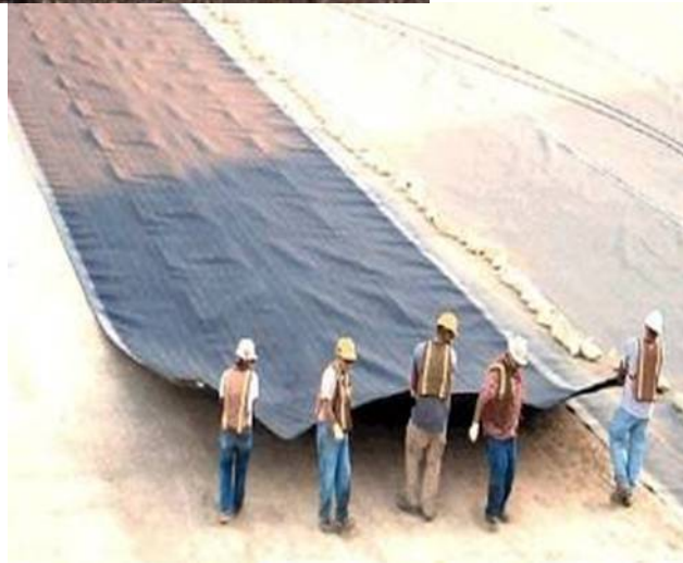
Постављање доње непрпусне фолије
