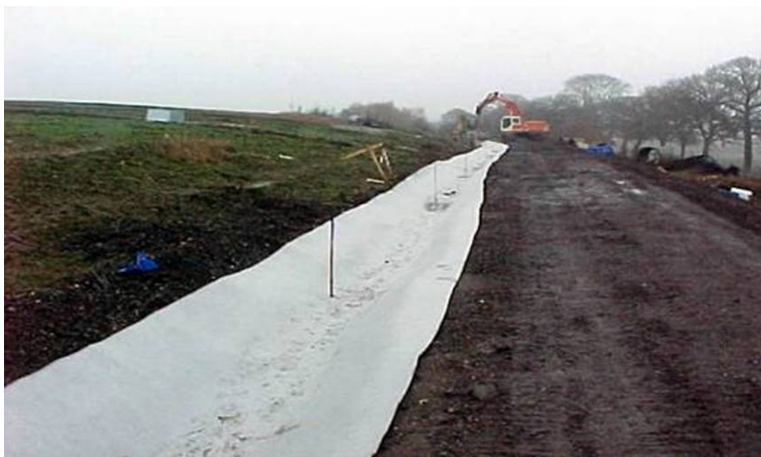
Приказ депоније са ободним каналима за отицање воде са фолије
